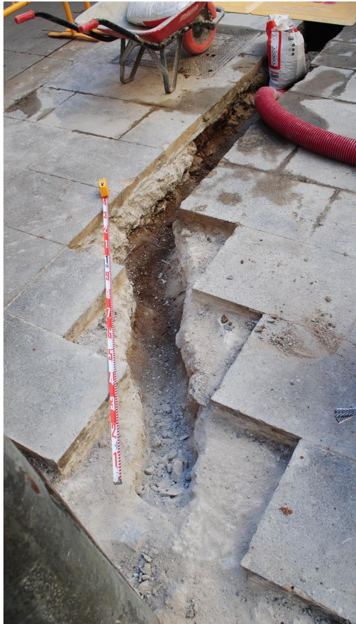
Imatge 4. Rasa i excavació del forat on anirà el nou fanal.
