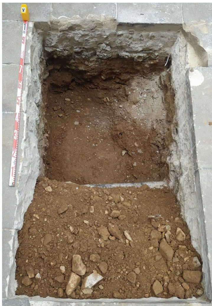
Imatge 5. Excavació d'on anirà la ubicació del nou fanal.
