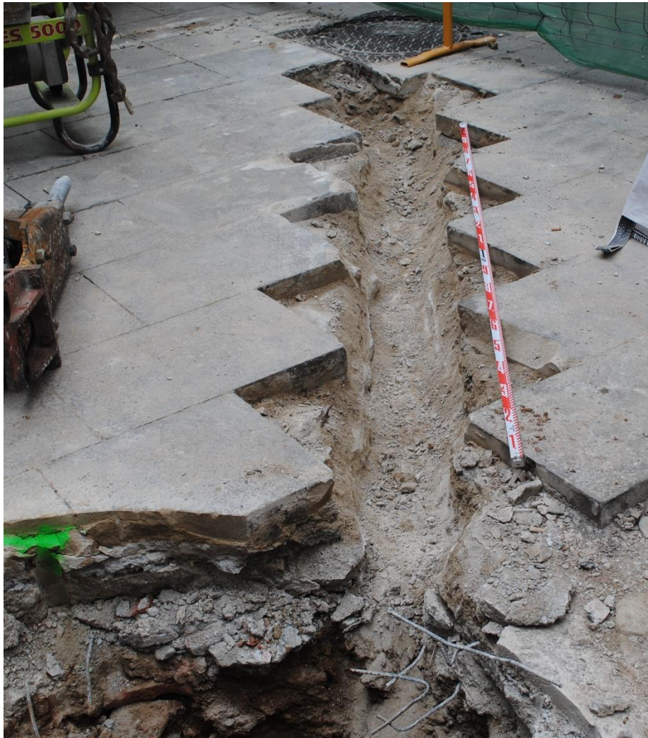
Imatge 3. Rasa que uneix el pou excavat per l'arbre amb la xarxa de clavegueram.
