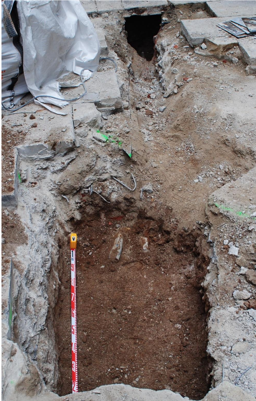
Imatge 2. Rasa del connector d'aigua potable amb l'excavació de l'arqueta en primer terme.
